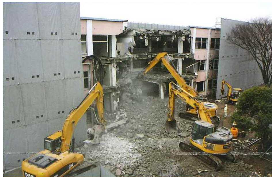
平成24年 特別教室棟の解体
