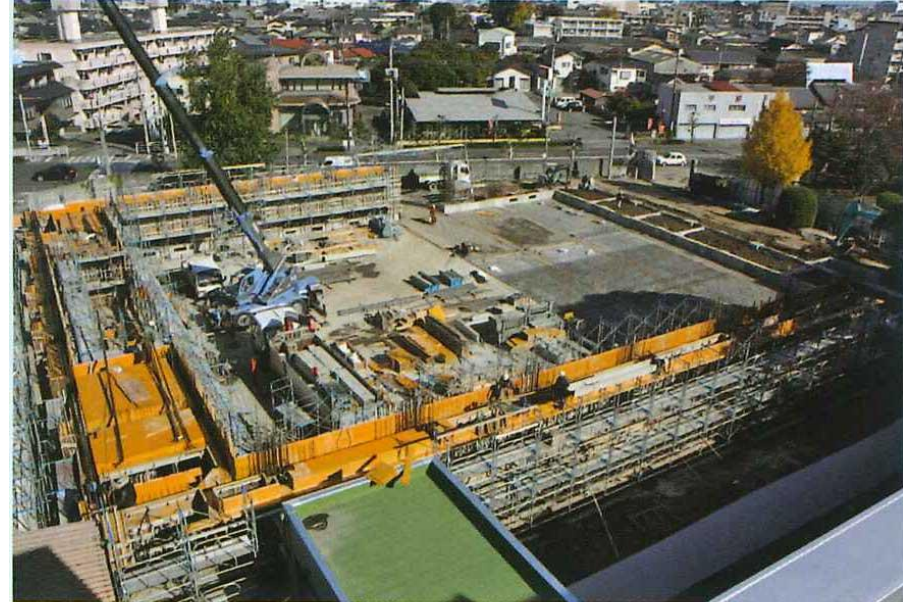
平成24年 体育館の改築工事開始
