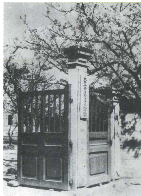
北校舎(旧中津高等女学校)正門
