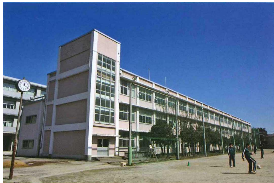
特別教室棟（解体前）
