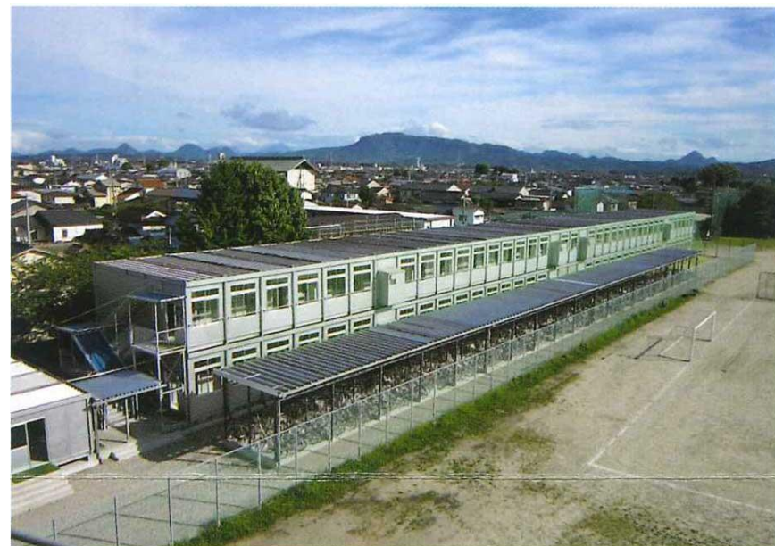
プレハブ校舎 新校舎建築中の間、教室棟として使用（現在のテニスコート付近に設置）
